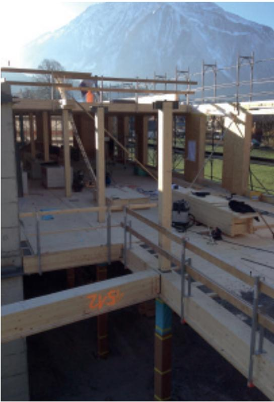
A sinistra, una fase di lavorazione del primo piano con la struttura portante in pilastri e travi collegati da elementi metallici.
