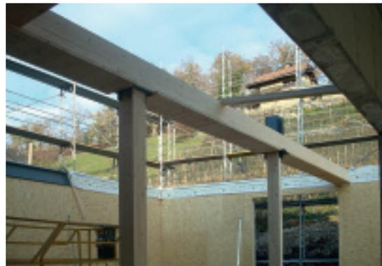
A destra, pilastri e travi in legno della struttura vengono completati dai tamponamenti prefabbricati delle pareti.
