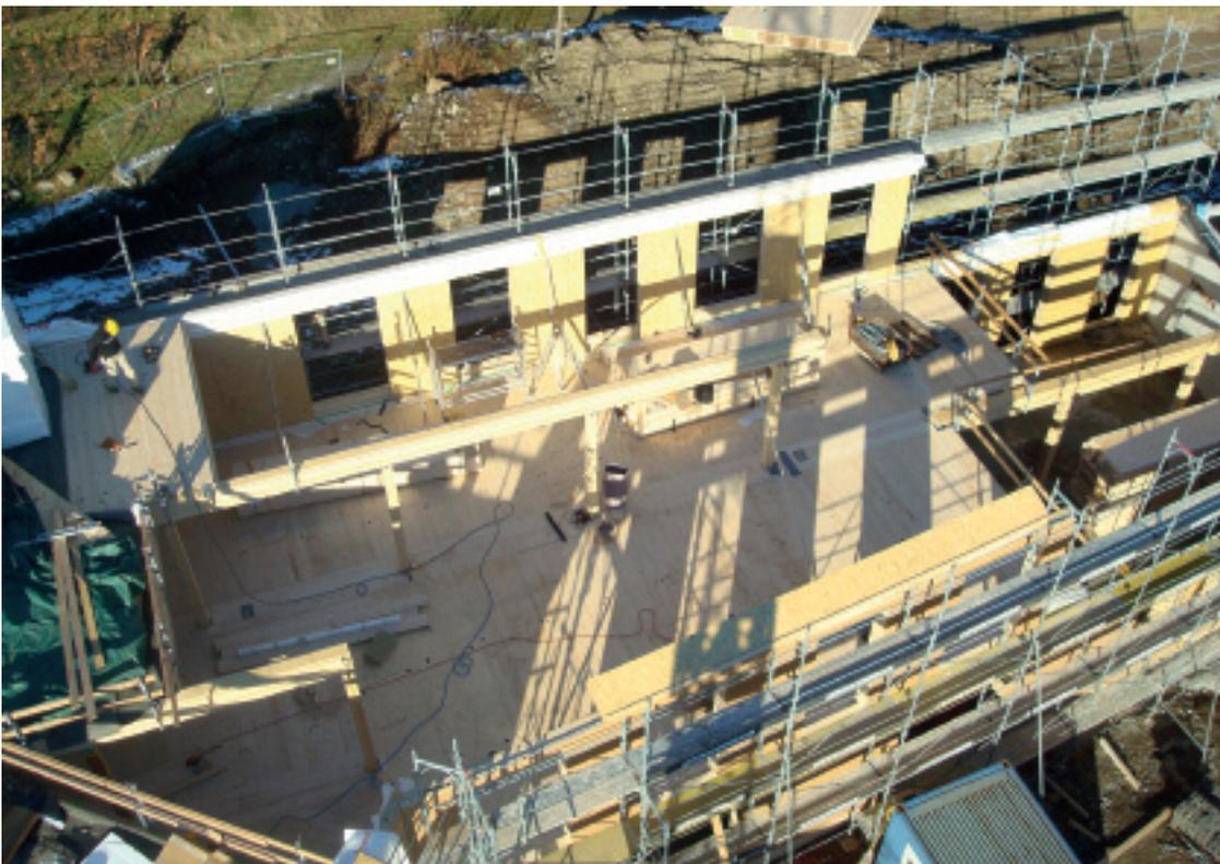
Un'immagine dalla gru; si noti l'avanzare della posa degli elementi prefabbricati dei solai, sia del primo piano sia della copertura.
